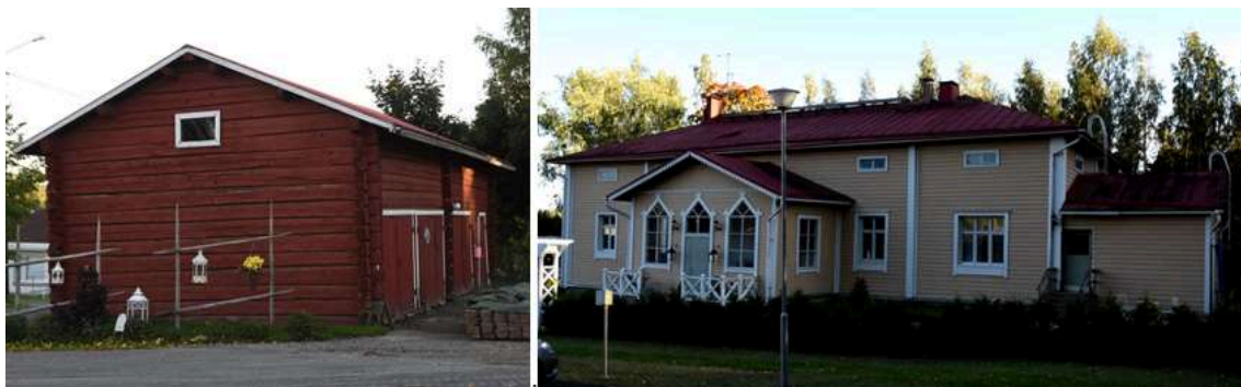
Kuvat 24. ja 25. Vasen kuva, aittarakennus. Oikealla Suur-Pappila
