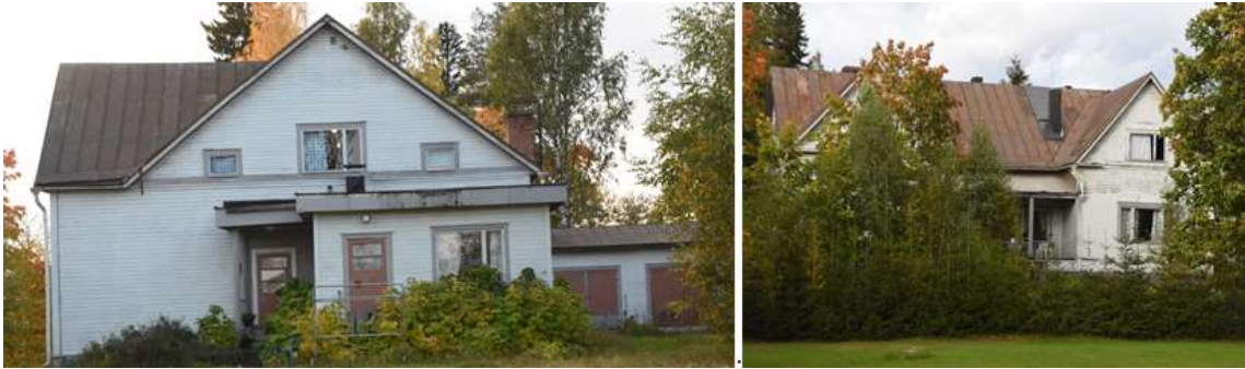
Kuvat 28. ja 29. Puistorinne, ent. Lääkärintalo
